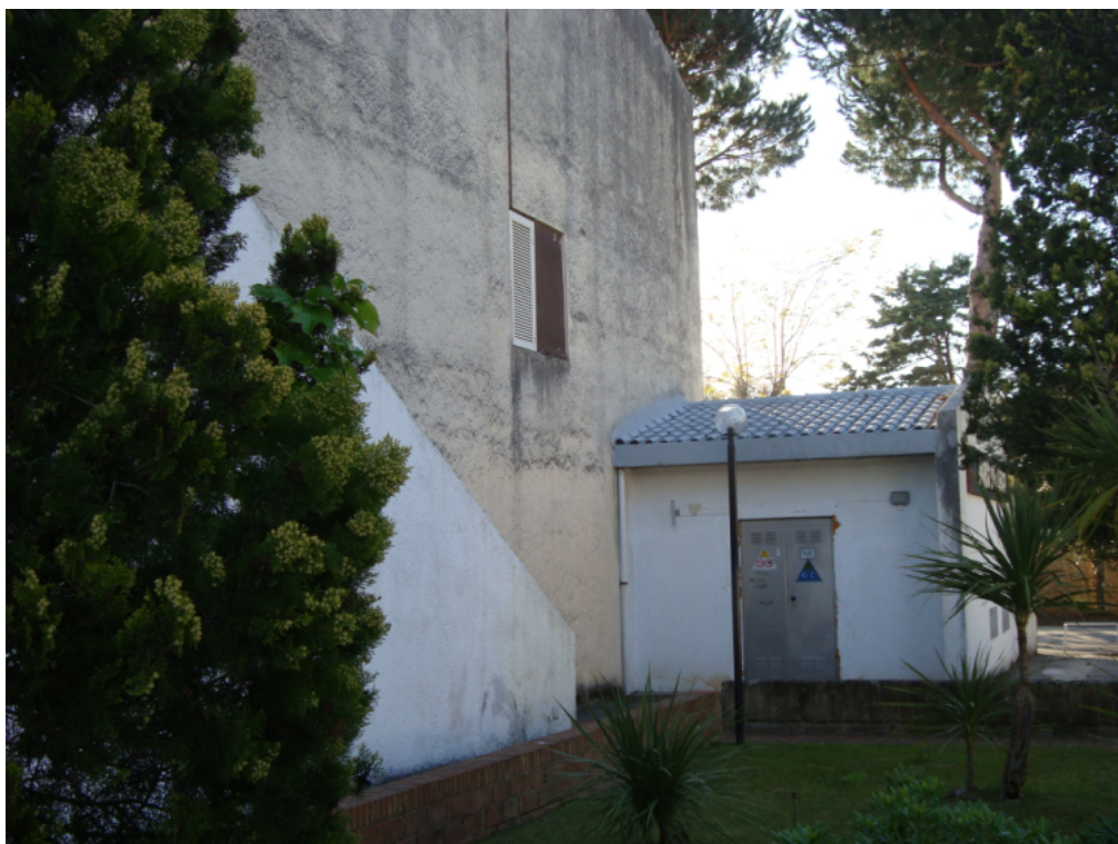
Immagine 27 – cabina enel
